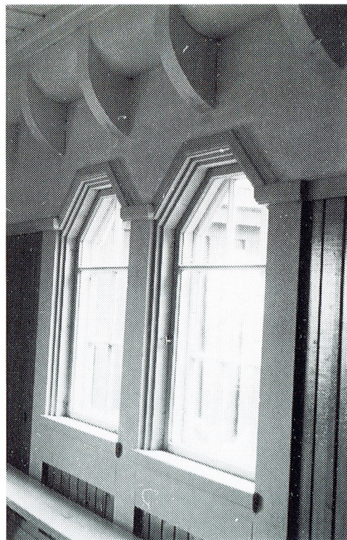
Kövra nya baptistkapell. Fönster på läktaren i stora samlingsalen. Notera också takbjälkarna.
