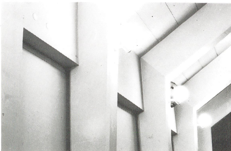
Folkets Hus, Hede. Detalj, takbjälkar i stora salen.
